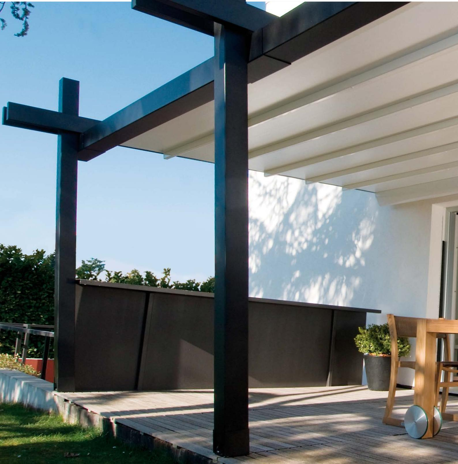
La evolución moderna y tecnológica de la estructura de la pérgola. Se diferencia por la original disposición del perfil delantero con los perfiles de guía en forma de cruz.
